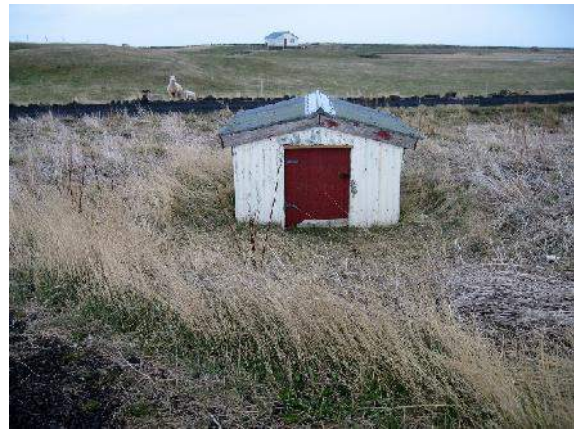
Hús yfir brunni 005, horft til norðurs
