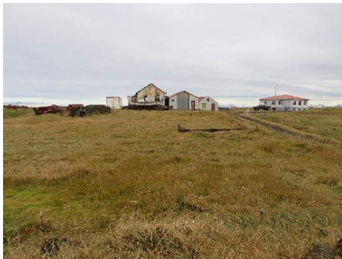
Horft til norðausturs yfir bæjarstaði Neðri-Brunnastaða 001. Vinstra megin við gamla íbúðarhúsið sést hlaðinn veggur í fjárhúsum 006
