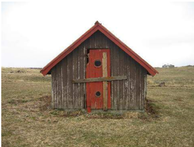
Hús yfir brunni 003, horft til norðausturs
