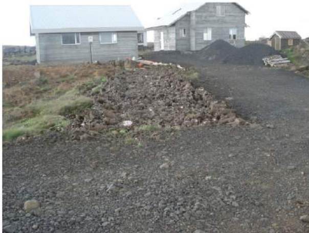
Vegur 031, horft til vesturs
