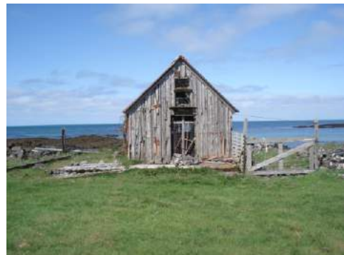
Hús 010, horft til norðurs
