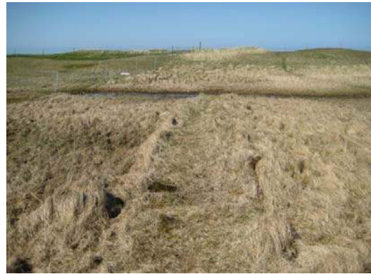
Upphlaðinn vegur á leið 052, horft til norðvesturs
