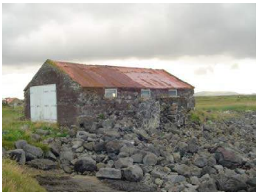
Leifar af mannvirkjum 009A-B, horft til suðurs
